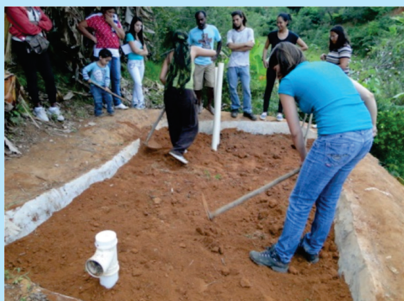
Camada final de terra
