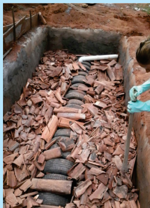
1ª Camada – entulho ou pedra de mão
